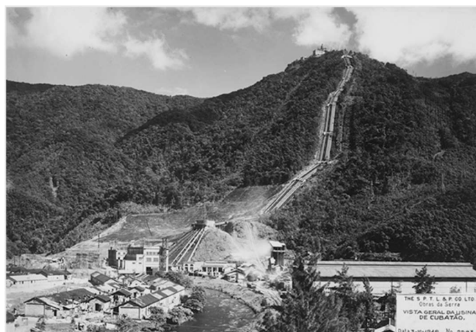
Figura 6.7 - Usina Henry Borden, de Cubatão. 1948. Acervo da Fundação Energia e Saneamento Fonte: http://alosaopaulo.com.br/memoria-de-sp-usina-henry-borden-os-90-anos-do-projeto-da-serra/
