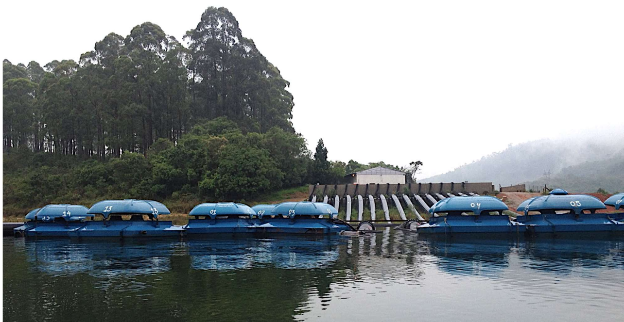
Figura 3.3 - Sistema de bombeamento de água no reservatório Atibainha, foto de 22/10/15, M. Pompêo
